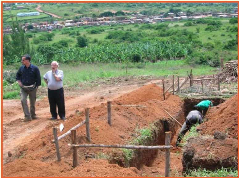
Padre Paolino e Mauro Lenzi visitano un cantiere dove sorgerà una nuova scuola
