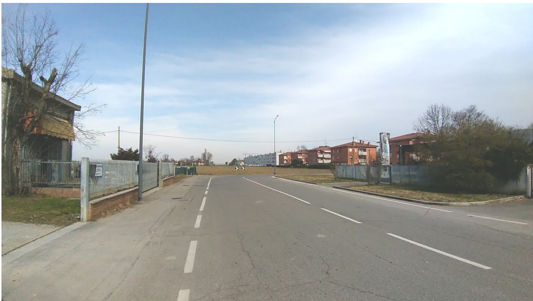
Fig. 2.4 – Foto 2 di via Stalingrado in direzione nord
