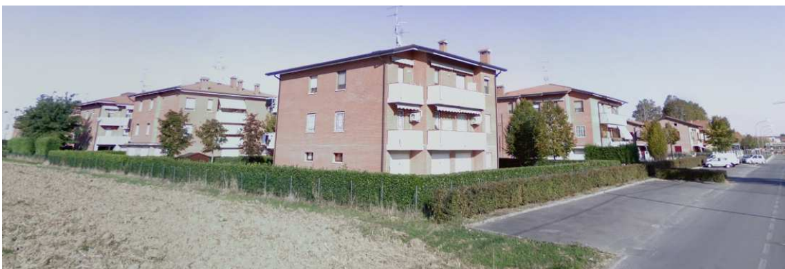
Vista sul fronte residenziale in affaccio su via Stalingrado (ramo est) – classe II
